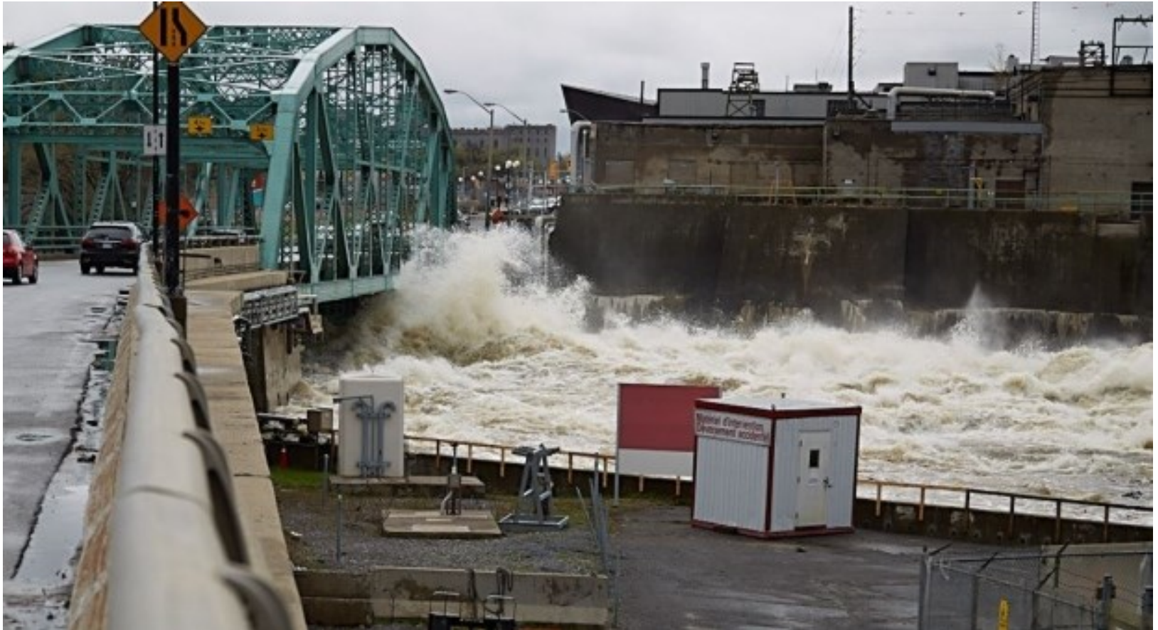
J.D. Comtois, CBC , Chaudière Bridge
